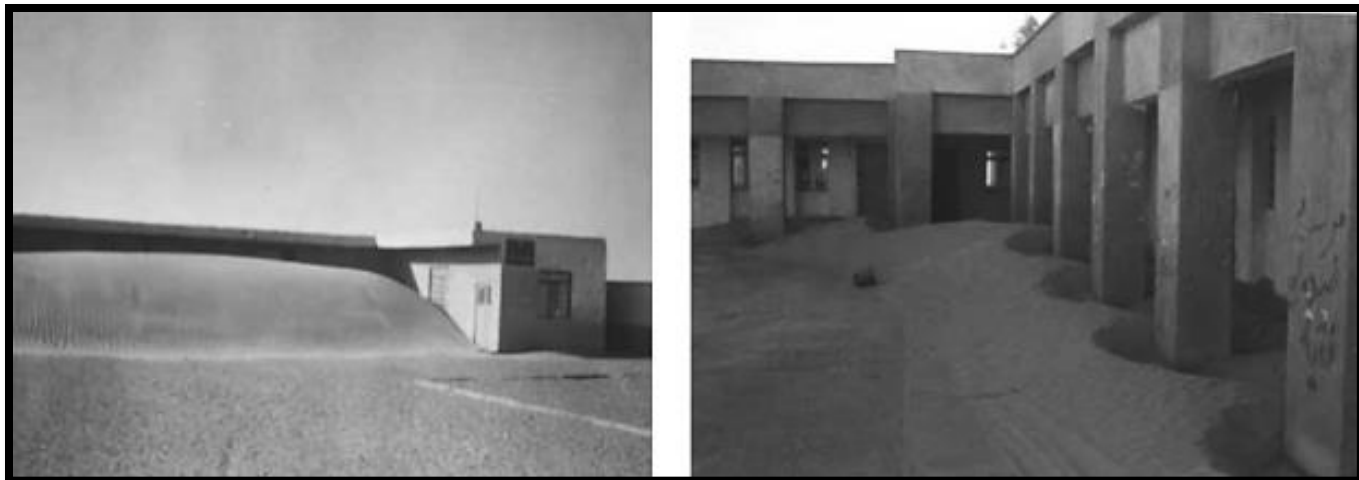
شکل ۱۵. تجمع ذرات شن و ماسه در حیاط مدارس و همچنین جلوی درب کلاس‌ها و درب ورودی مدارس.
