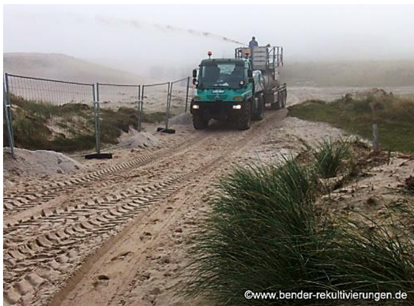
شکل ۲۷. پایدار کردن سطوح خاک با استفاده از مواد طبیعی و مصنوعی.
